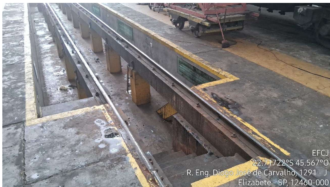
Figura 27 - Manchas de vazamento de óleo providos de truck do vagão de passageiros, por sobre piso com trincas - Pátio de Manutenção Capivari
