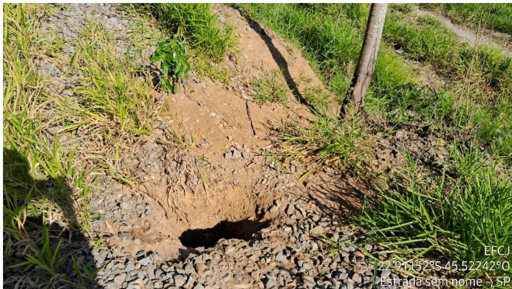
Figura 34 - Erosão laminar à jusante da via permanente
