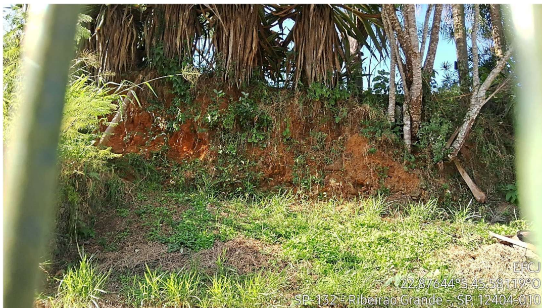
Figura 48 - Erosão laminar em talude - Entrada do Parque Reino das Águas Claras
