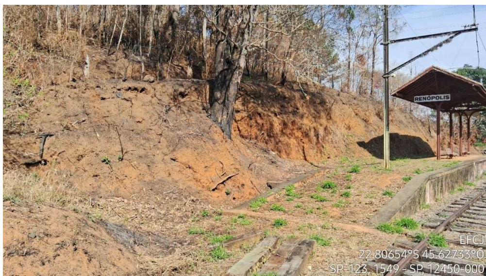
Figura 59 - Talude com processos erosivos intensos - Parada Renópolis
