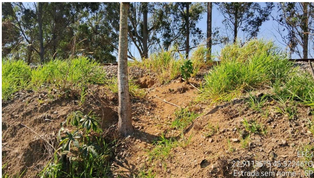
Figura 35 - Erosão laminar à jusante da via permanente
