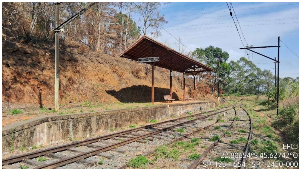
Figura 60 - Talude com processos erosivos intensos - Parada Renópolis
