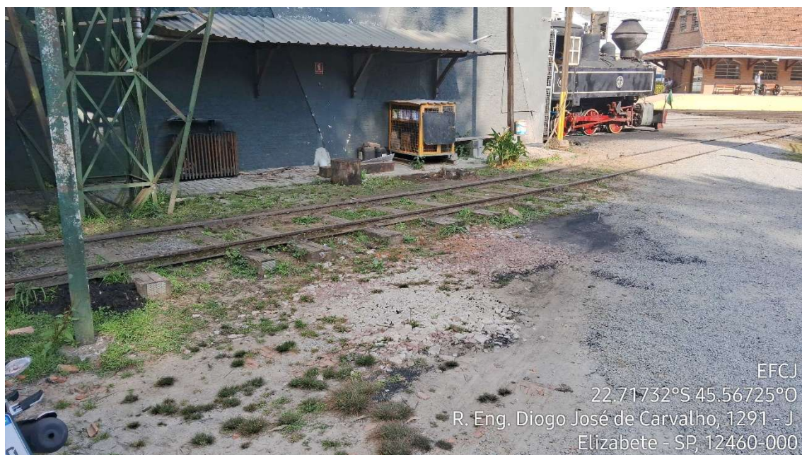
Figura 23 - Manchas de óleo por sobre a brita em área de estacionamento de locomotivas - Pátio de Manutenção Capivari
