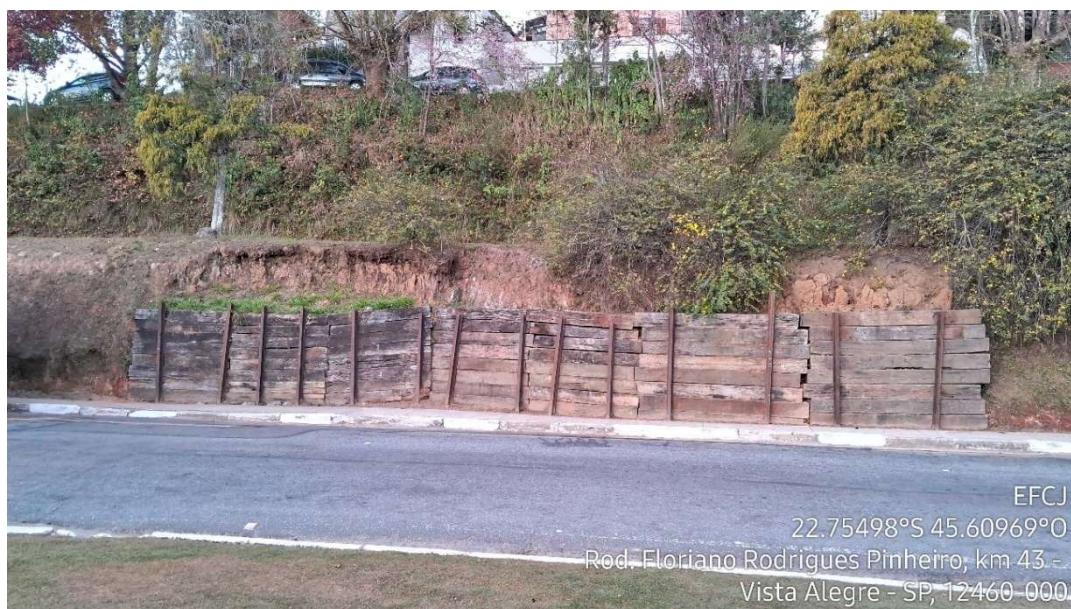
Figura 77 - Contenção improvisada com trilhos e dormentes
